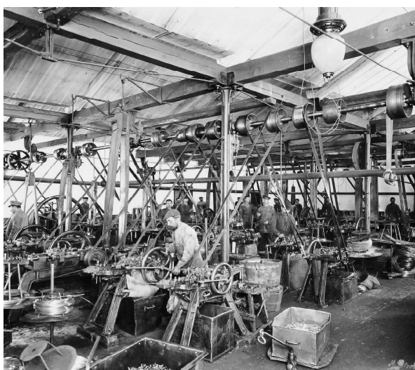
Stroje na obuvnické cvoky s dřevěnými péry ukotvenými na trémové konstrukci, a transmisemi roku 1904 v Hlubočkách / Zdroj: Zemský archiv v Opavě, pracoviště Olomouc, fond Moravia, a.s. pro průmysl železářského zboží a obchodu v Hlubočkách a Mariánském Údolí
