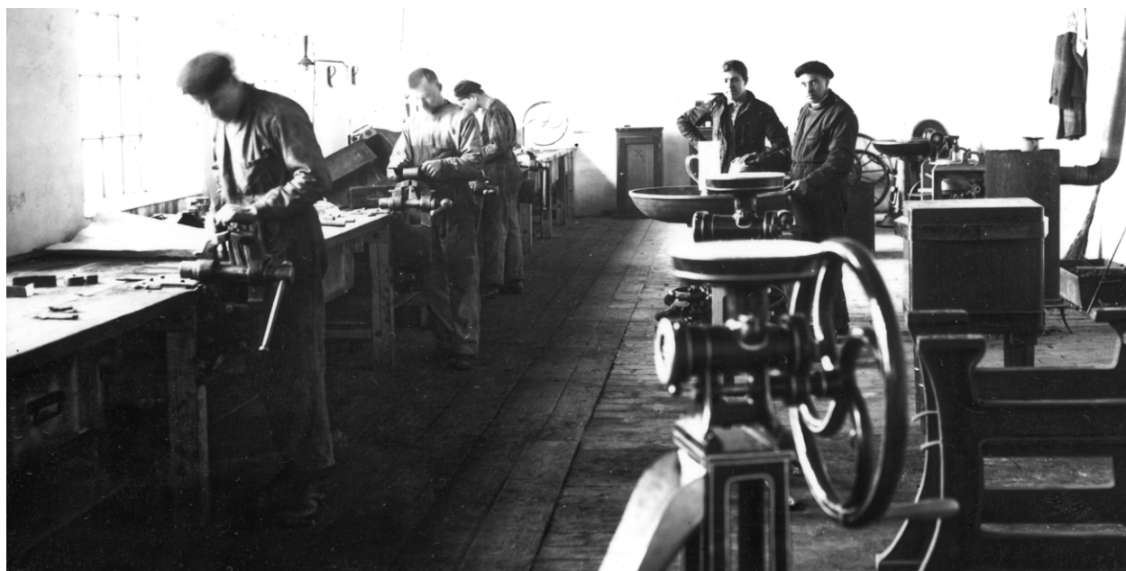
Obr. 4/ Zámečnická dílna Strojírny Bruna, nákupního, prodávajícího a výrobního družstva Moravských řezníků a uzenáříů, Brno Antonínská 22. V dílně se zhotovují komponenty k výrobě řeznických strojů. Fotoalbum, 20.-30. léta 20. Století. Sbíрка TMB, 02.03-67.
