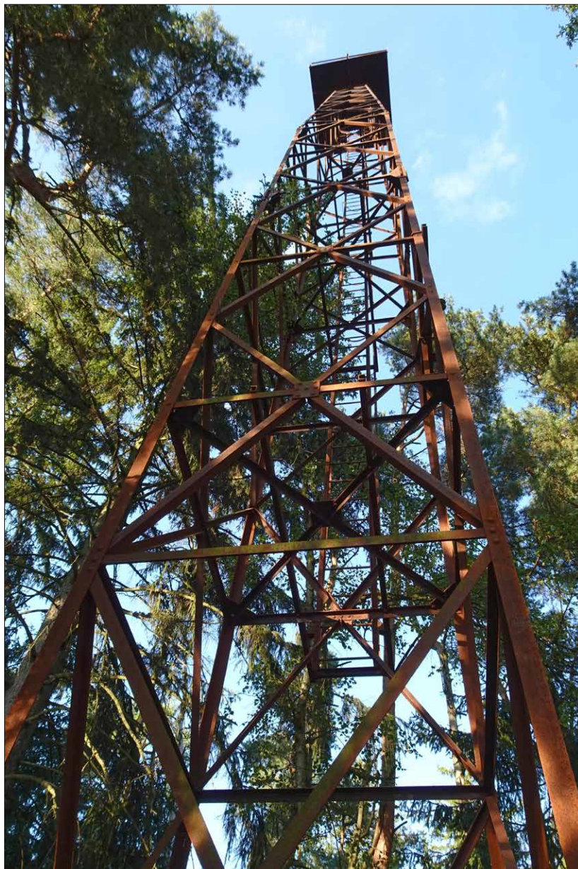
Letecký maják číslo 8 (Bobrůvka) na trati Praha – Brno – Bratislava, dnešní stav Foto T. Příbyl (TMB)
