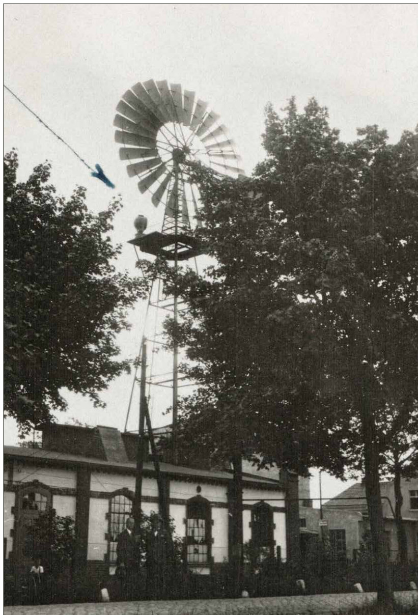
K umístění leteckého majáku u Werneuchenu (Německo) bylo použito ochozu věže větrného kola. Ze zahraniční studijní cesty pánů J. Kareze, J. Najbrta a F. Stočesa Foto NA, MVP, kart. 1351, 13a-4/81, 52447, 1929
