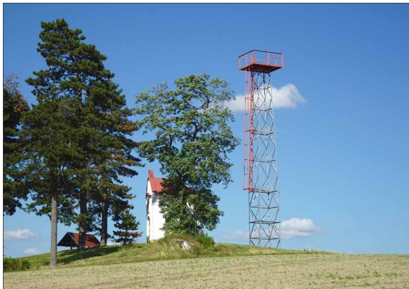
Letecký maják číslo 6 (Česká Bělá) na trati Praha – Brno – Bratislava, dnešní stav Foto T. Příbyl (TMB)
